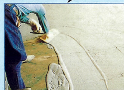
エポキシ下地の改修
