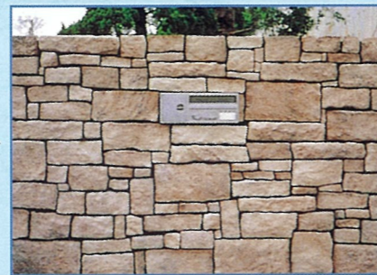
大型石材タイル張り
