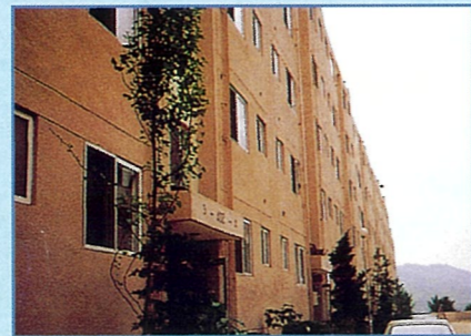
吹付け下地の改修
