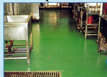
工場床の改修
