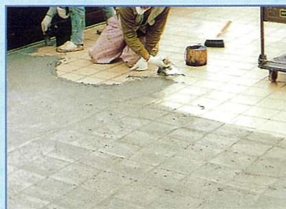
旧タイル下地の改修
