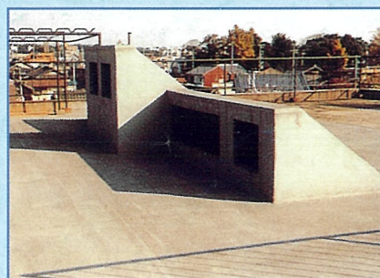
防水下地の改修
