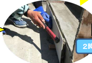
墨・水糸に合わせて微調整
