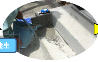
専用踏面レベラーを流す
